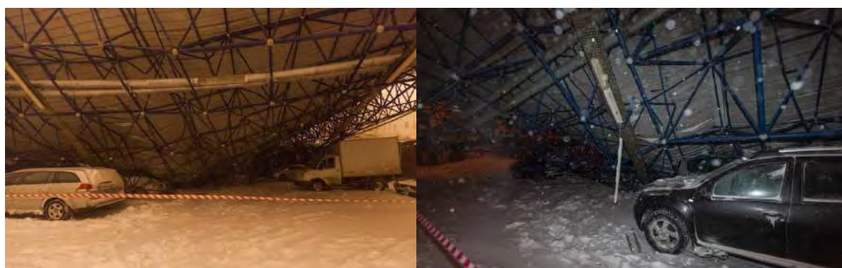
Рисунок 4.2 - Обрушение навеса автостоянки в г. Минске 15.03.2013 г.
